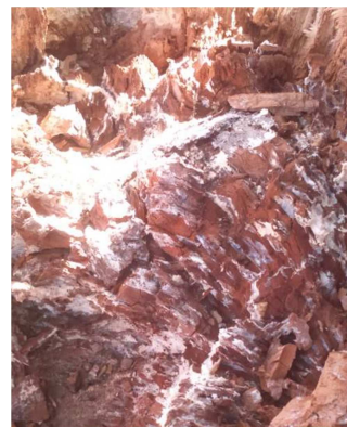
Photo 6 : dégradation du bois dû au Polypore soufré
